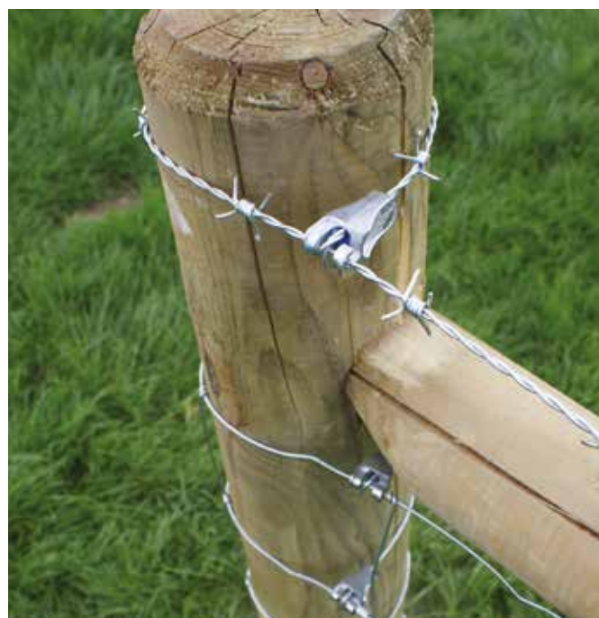
Giunzioni T-Clip2 utilizzate per la finitura del filo spinato
