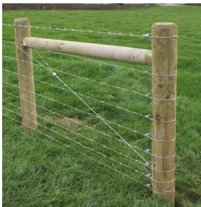
FPAK - Installato su palo di forma H
