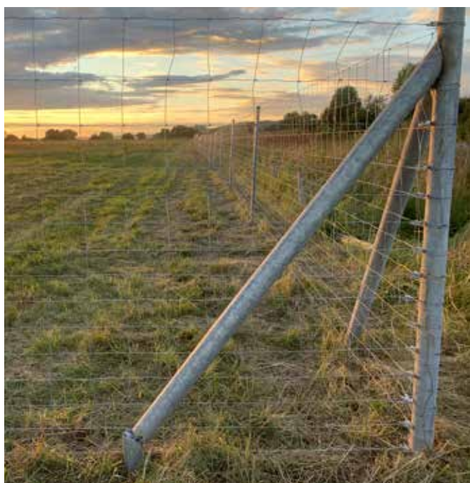
Giunzioni T-Clip fissate al recinto per bestiame
